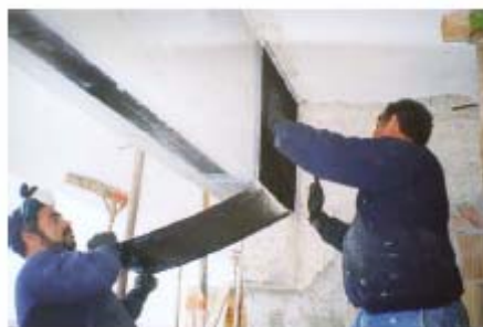
Σχήμα 3: Ενίσχυση δοκού σε διάτμηση [15]
