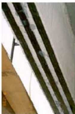
Σχήμα 2 : Ενίσχυση δοκού σε κάμψη [15]
