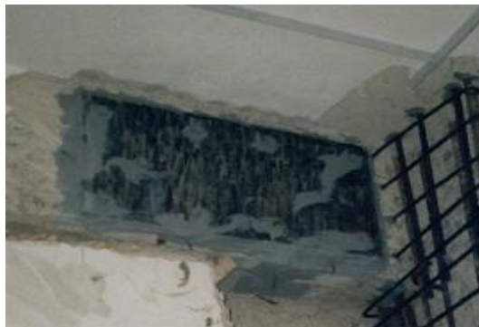
Σχήμα 6 : Ενίσχυση δοκού με μεταλλικό έλασμα [15]
