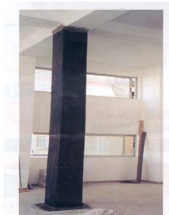
Εικόνες 8 και 9 :Ενίσχυση υποστυλωμάτων με FRP [19]
