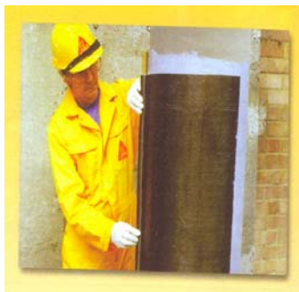
Εικόνες 8 και 9 :Ενίσχυση υποστυλωμάτων με FRP [19]
