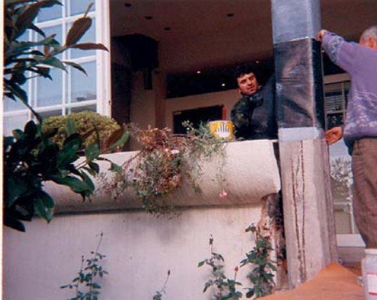
Εικόνα 11 : Ενίσχυση υποστρώματος με FRP [internet, site www.episkeves.civil.upatras.gr ]
