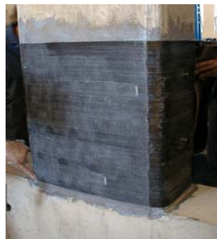
(γ) επάλειψη μανδύα με ρητίνη και τοποθέτηση επόμενων στρώσεων
