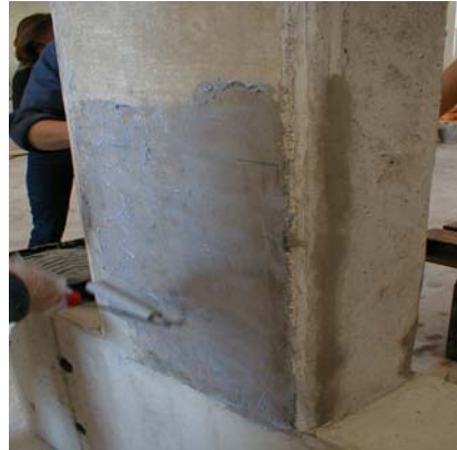
(β) τοποθέτηση πρώτης στρώσης επ. ρητίνης και κονιάματος
