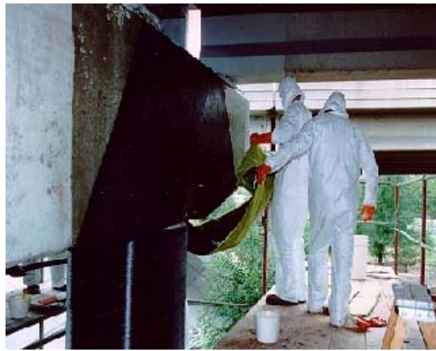
Εικόνα 5: Ενίσχυση υποστυλώματος με χρήση μανδύα από FRP [8].
