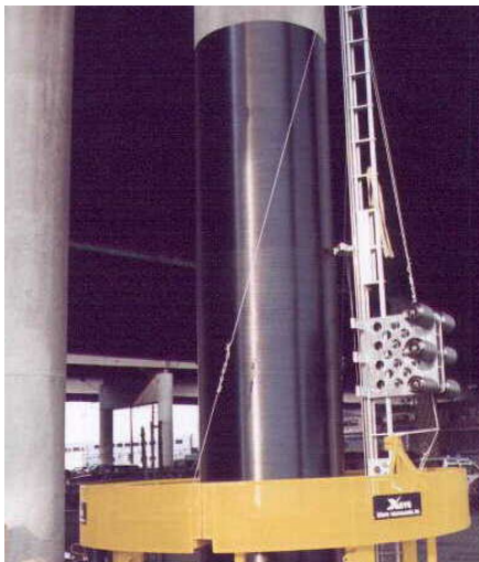
Εικόνα 4: Ενίσχυση υποστυλώματος με χρήση μανδύα από FRP [8].
