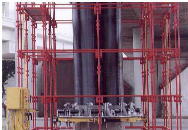
Εικόνα 7: Ενίσχυση υποστυλώματος με χρήση μανδύα από FRP [8].
