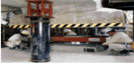
Φώτ.4 : Τοποθέτηση ελαστομεταλλικού εφεδράνου.
