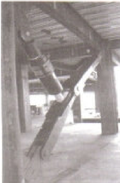
Σχήμα 3: Διάταξη toggle brace στο Yerba Buena Tower
