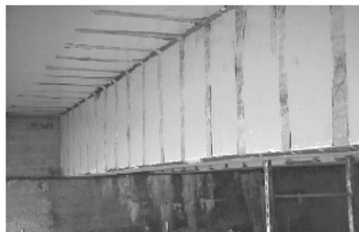
Σχ. 11 Τοποθετημένα φύλλα FRP.
