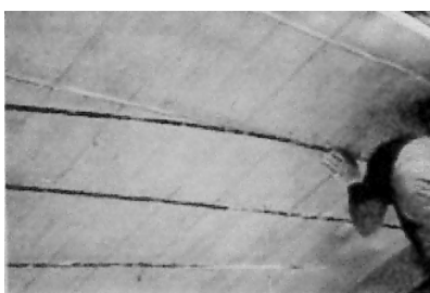
Εφαρμογή σε κατάστρωμα γέφυρας.[2]
