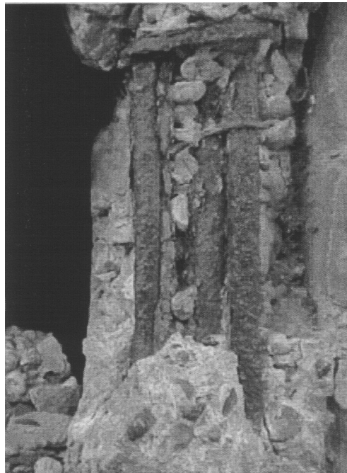
Σχ. 59. Ρηγμάτωση του σκυροδέματος λόγω διαβρώσεως του ενσωματωμένου χάλυβα.
