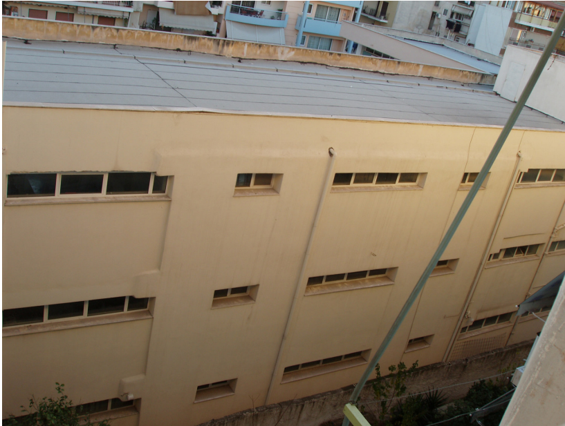
Σχ7. Βόρεια όψη τμήματος II μετά την επισκευή
