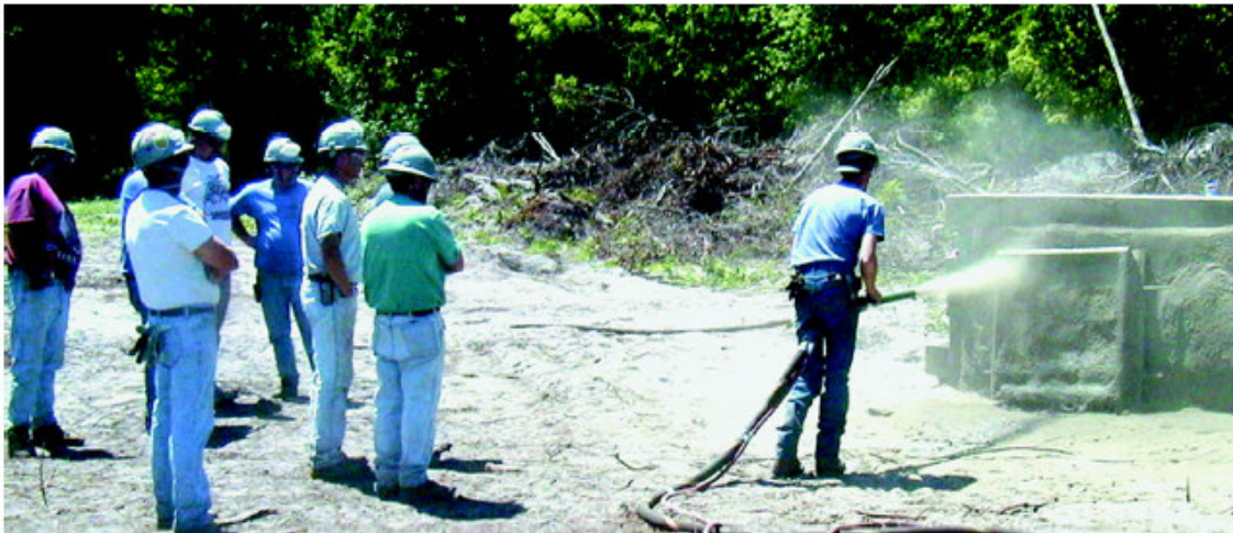
Εικόνα 2: Παραγωγή δοκιμαστικών πανέλων (Shotcrete Magazine, Fall 2000)
