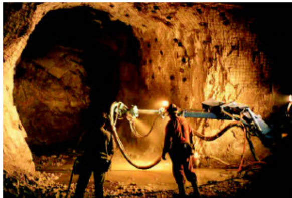
Εικόνα 1: Χρήση εκτοξευόμενου σκυροδέματος σε υπόγεια σήραγγα (Shotcrete Magazine, Fall 2000)
