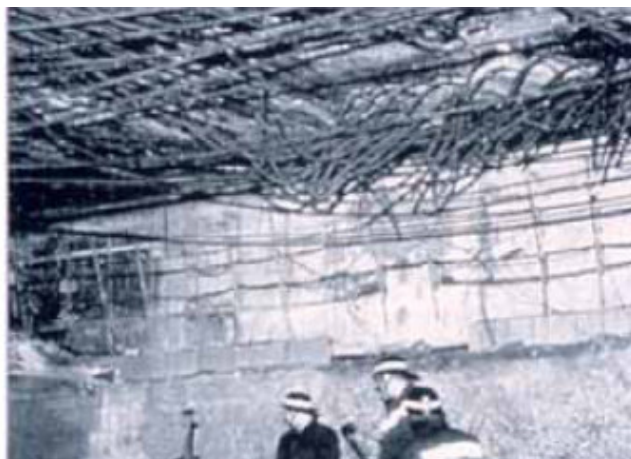
Εικόνα 29 και 30. Moorfleet Tunnel (ορθογωνικής διατομής), με πάχος επένδυσης 1 m από προενταμένο σκυρόδεμα, σοβαρή αποκόλληση στην οροφή και στα πλαϊνά τοιχώματα, έφυγε η επικάλυψη από τις προεντεταμένες ράβδους οι οποίες επιμηκύνθηκαν )
