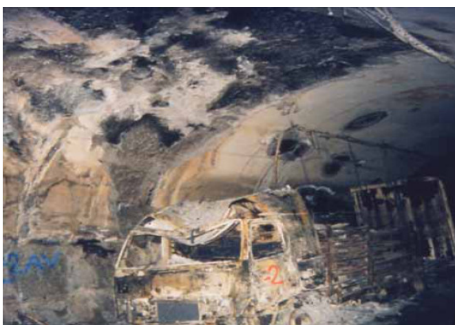
Εικόνα 31 και 32. Euro Tunnel, σοβαρή αποκόλληση, απώλεια φέρουσας ικανότητας, μερική κατάρρευση, χρειάστηκαν 6 μήνες για επισκευή με συνολικό κόστος 350 εκατ. $ .
