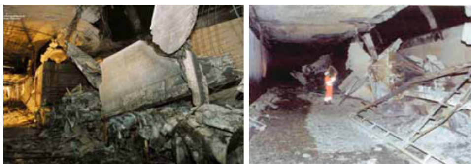
Εικόνα 26 , 27 και 28. Gotthard Tunnel, μέγιστη θερμοκρασία 1200 °C + ,σοβαρή αποκόλληση, χρειάστηκαν 2 μήνες για επισκευή .
