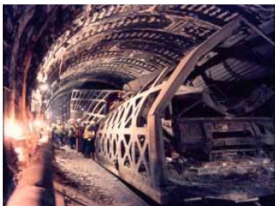
Εικόνα 31 και 32. Euro Tunnel, σοβαρή αποκόλληση, απώλεια φέρουσας ικανότητας, μερική κατάρρευση, χρειάστηκαν 6 μήνες για επισκευή με συνολικό κόστος 350 εκατ. $ .
