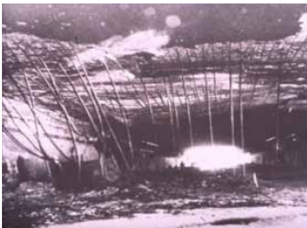
Εικόνα 29 και 30. Moorfleet Tunnel (ορθογωνικής διατομής), με πάχος επένδυσης 1 m από προενταμένο σκυρόδεμα, σοβαρή αποκόλληση στην οροφή και στα πλαϊνά τοιχώματα, έφυγε η επικάλυψη από τις προεντεταμένες ράβδους οι οποίες επιμηκύνθηκαν )
