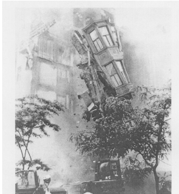
Φωτογραφία 4. Κατάρρευση του Ξενοδοχείου Vendome στην Βοστώνη κατά την διάρκεια πυρκαϊάς
