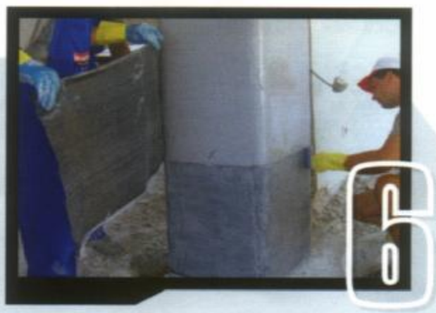
Σχ4 Τοποθέτηση υφάσματος
