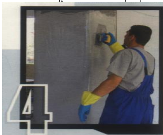
Σχ2 Αποκατάσταση επιφάνειας υποστρώματος με καθαρίσμα και τρίψιμο
