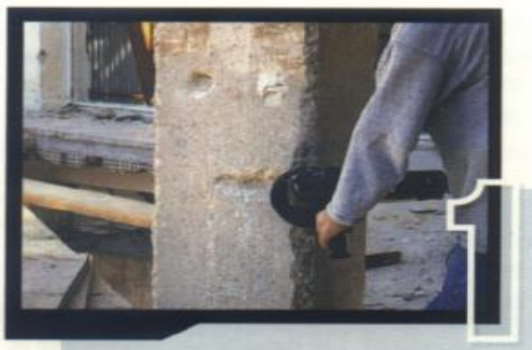
Σχ2 Αποκατάσταση επιφάνειας υποστρώματος με καθαρίσμα και τρίψιμο
