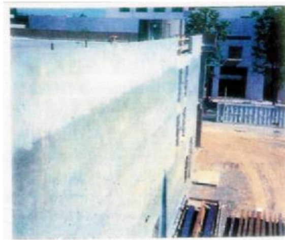
Φότο 3: Το έργο στην πλατεία Capitol, η χρωματική διαφορά είναι αποτέλεσμα της διαφορετικής τεχνικής αποπεράτωσης που χρησιμοποιήθηκε, για αρχιτεκτονικούς λόγους. Η κορυφή είχε πρασινωπό χρώμα , ενώ ο υπόλοιπος τοίχος έχει χρώμα ξύλου (M. Isaak & C. Zynda, 1992)
