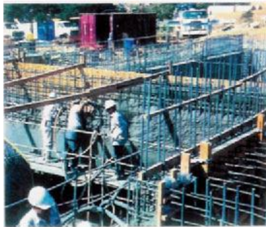
Φώτο 4: Διάστρωση εκτοξευομένου σκυροδέματος στο κτίριο της Hewlett Packard (Concrete International, May 1992)
