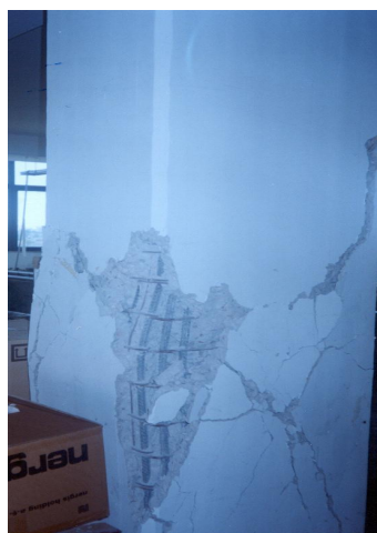
Φ.10 Τατοίου 248 Εργοστάσιο Μιχαλίδη
