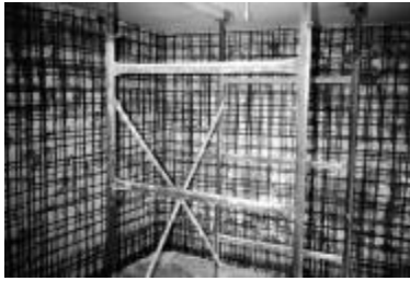
εικ.14(εσωτερική πλευρά τοίχου, διπλό πλέγμα οπλισμού)
