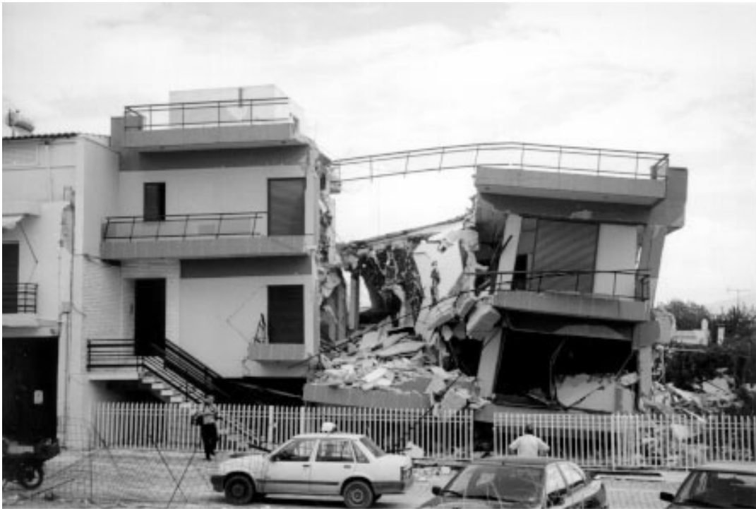
Σχ. 2 Σεισμός Αθήνας 7.9.1999. Κατάρρευση κτιρίου με ύπαρξη πιλοτής.
