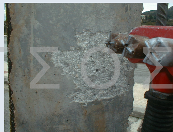
Προετοιμασία Επιφάνειας με Αεροματσάκονο
