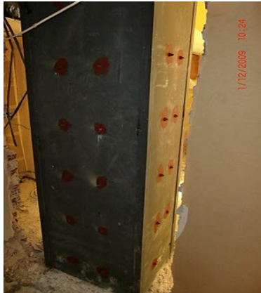
Εικόνα 3: Ενίσχυση υποστρώματος με μεταλλικό μανδύα [7]
