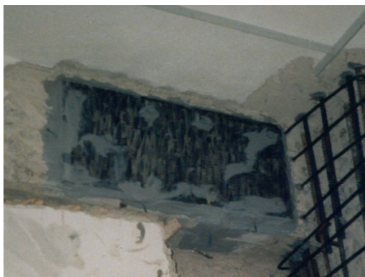
Εικόνα 1: Ενίσχυση δοκού με χαλύβδινα ελάσματα [5]
