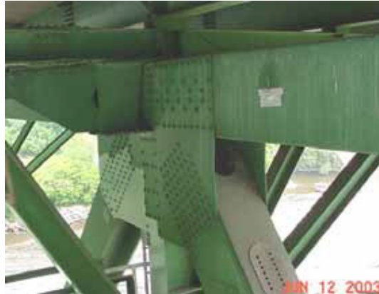
Σχήμα 9: Λυγισμός κομβοελασμάτων του φορέα U10[12]
