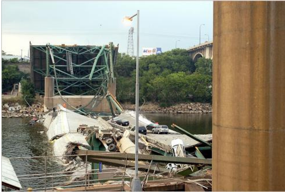
Σχήμα 8: Μετά την κατάρρευση της I-35W bridge[11]
