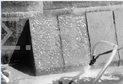
Εκτράχυνση με Αμμοβολή
