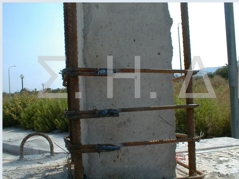
Ηλεκτροσυγκόλληση άκρων Συνδετήρων Μανδύα 23
