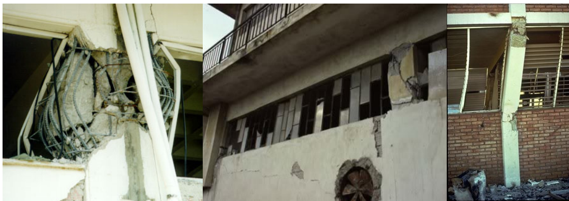
Σχήμα 1: Δυσμενής επιρροή στο σεισμό, λόγω ανομοιομορφίας κατανομής (εδώ κατακόρυφης) [5]
