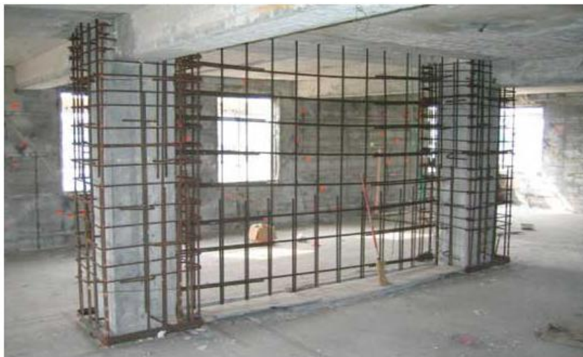
Σχήμα3: Εμφάντωση με πάχος ίσο με το πλάτους της δοκού[4]
