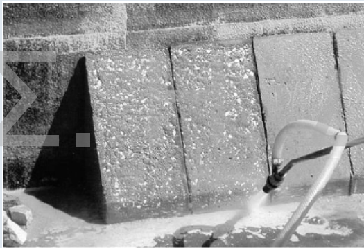
Εκτράχυνση με Αμμοβολή
