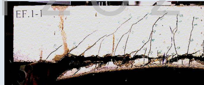
Απόσχιση επικάλυψης σκυροδέματος στο πέρας του σύνθετου υλικού
