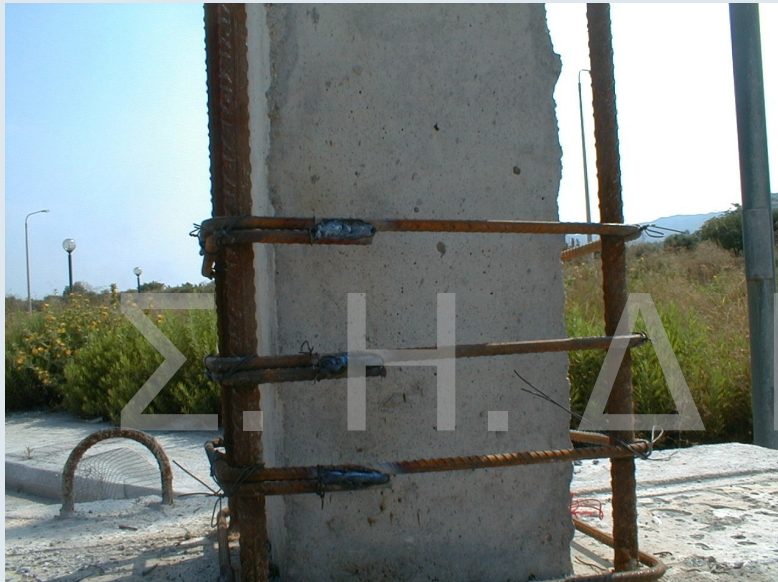
Ηλεκτροσυγκόλληση Άκρων Συνδετήρων Μανδύα 19
