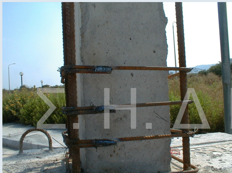
Ηλεκτροσυγκόλληση άκρων Συνδετήρων Μανδύα 23
