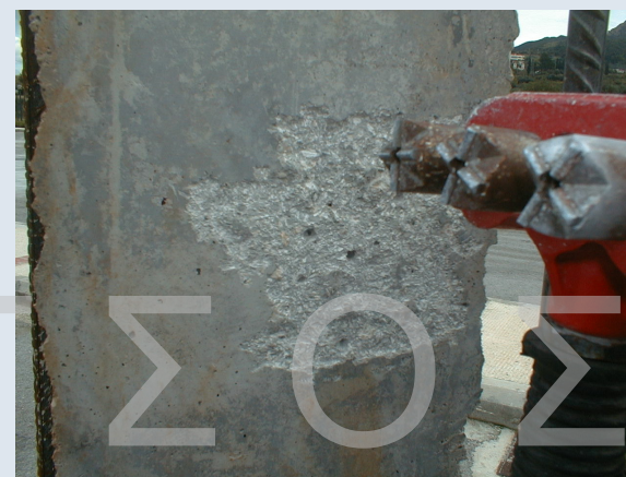
Προετοιμασία Επιφάνειας με Αεροματσάκονο
