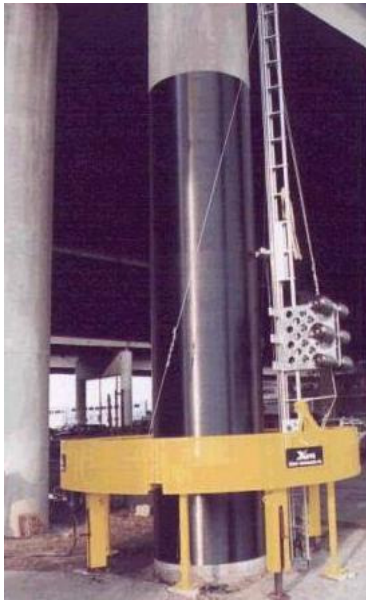
Εικόνα 2: Ενίσχυση με Robo-Warper
