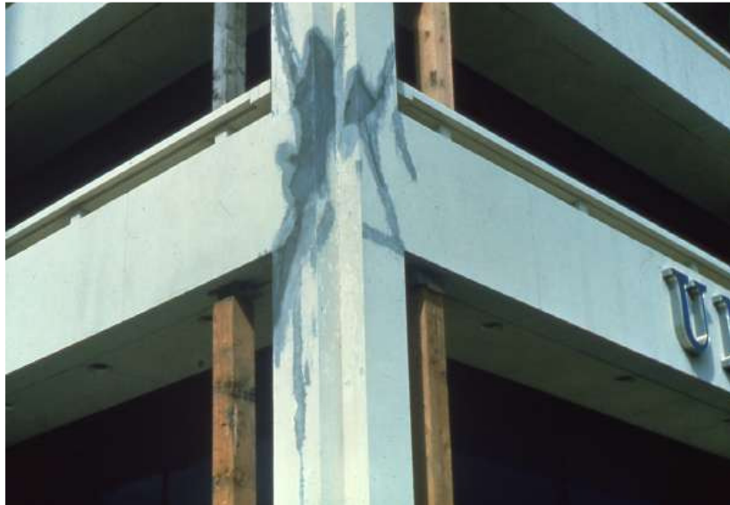
Σχήμα 1: Κόμβος μετά από ενίσχυση
