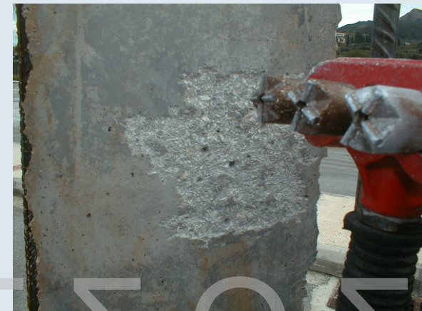
Προετοιμασία Επιφάνειας με Αεροματσάκονο
