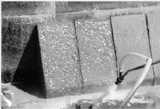
Εκτράχυνση με Αμμοβολή
