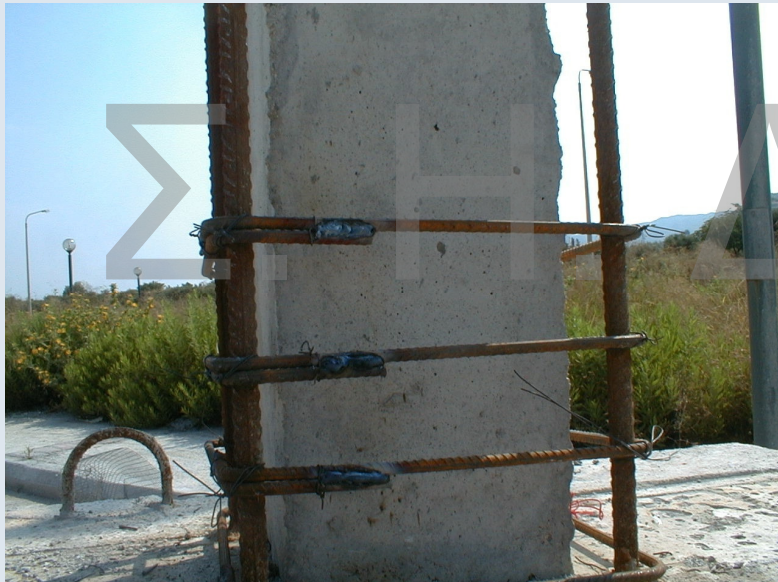
Ηλεκτροσυγκόλληση Άκρων Συνδετήρων Μανδύα 47
