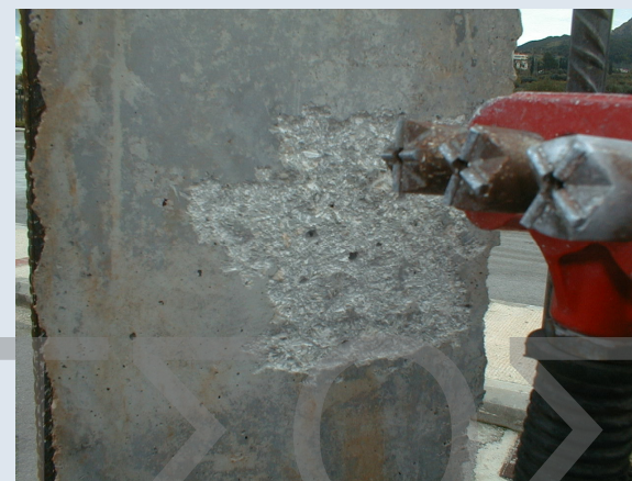
Προετοιμασία Επιφάνειας με Αεροματσάκονο
