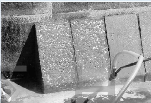
Εκτράχυνση με Αμμοβολή
