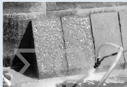
Εκτράχυνση με Αμμοβολή
