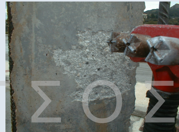
Προετοιμασία Επιφάνειας με Αεροματσάκονο
