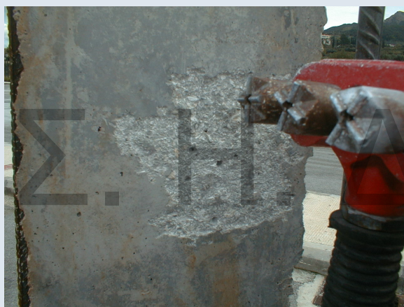
Προετοιμασία Επιφάνειας με Αεροματσάκονο
