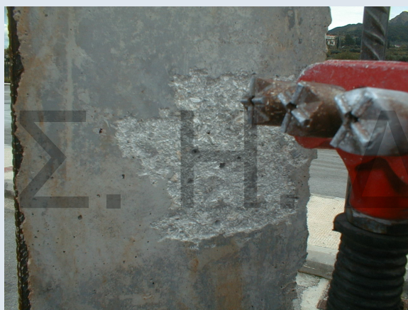
Προετοιμασία Επιφάνειας με Αεροματσάκονο
