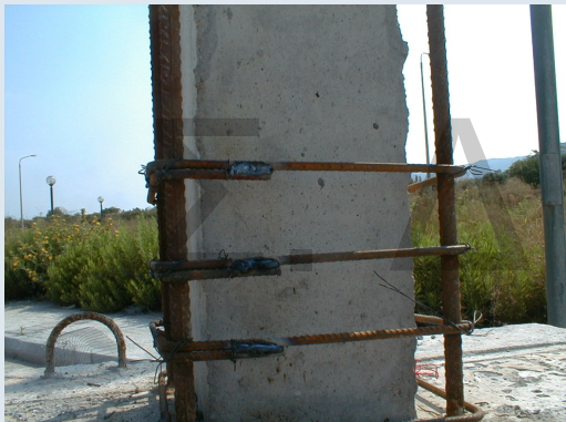
Ηλεκτροσυγκόλληση Άκρων Συνδετήρων Μανδύα
