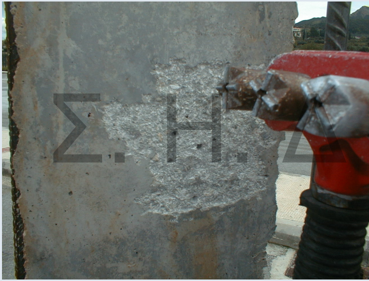
Χρήση Αεροματσάκων για Εκτράχυνση της Διεπιφάνειας 45
