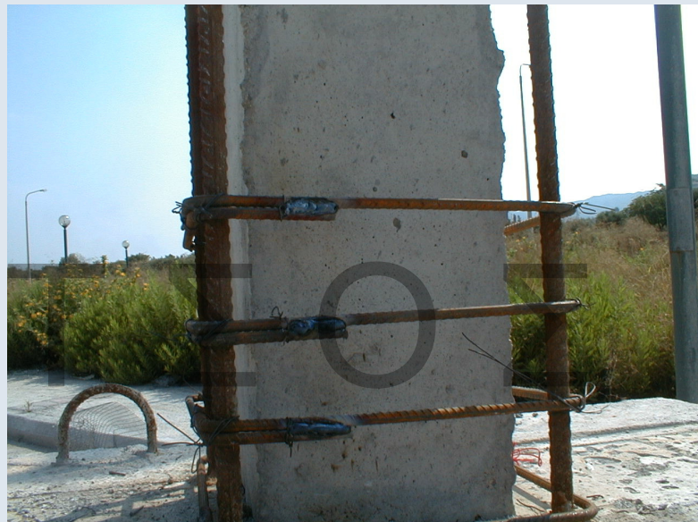
Ηλεκτροσυγκόλληση Άκρων Συνδετήρων Μανδύα
