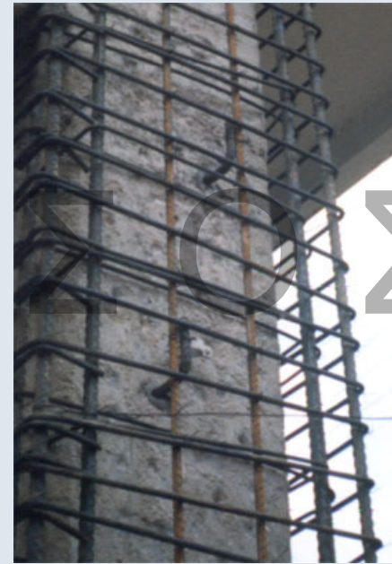
Εκτράχυνση και Χρήση Χαλύβδινων Βλήτρων
