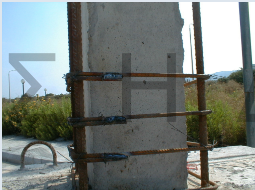
Ηλεκτροσυγκόλληση Άκρων Συνδετήρων Μανδύα
