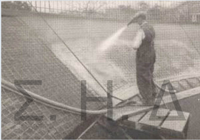
Εκτόξευση σκυροδέματος το 1919 για κατασκευή δεξαμενής νερού
