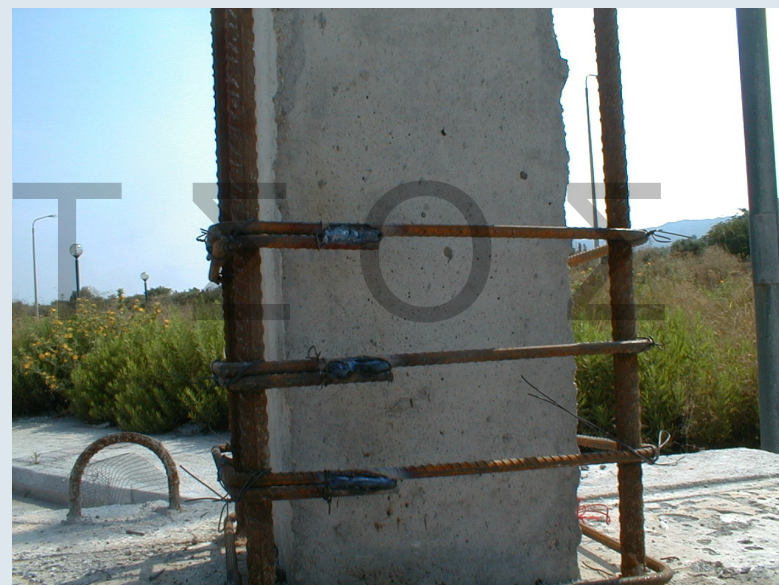
Ηλεκτροσυγκόλληση Άκρων Συνδετήρων Μανδύα
