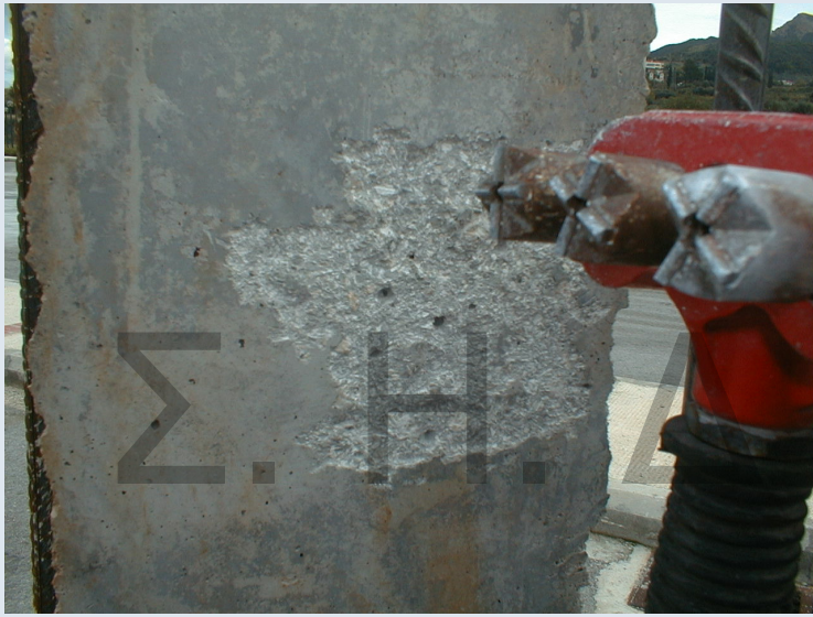
Χρήση Αεροματσάκων για Εκτράχυνση της Διεπιφάνειας
