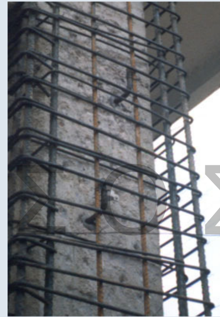
Εκτράχυνση και Χρήση Χαλύβδινων Βλήτρων
