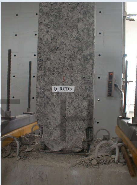
Βλάβες σε Δοκίμιο με Εκτοξευόμενο Σκυρόδεμα και Βλήτρα 49
