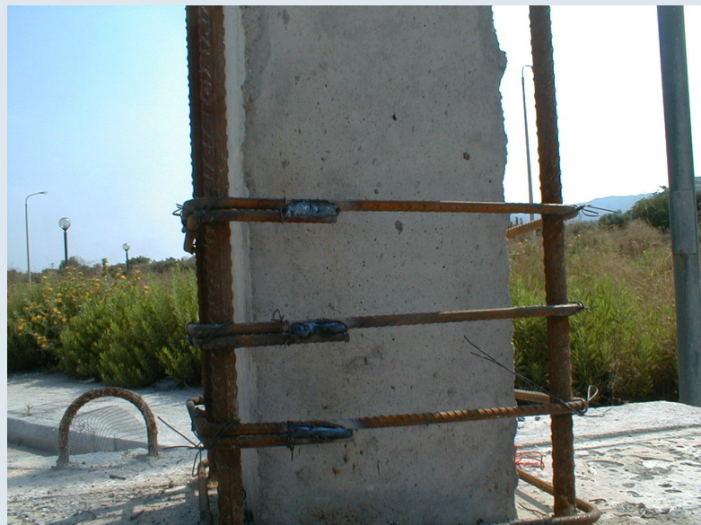
Ηλεκτροσυγκόλληση Άκρων Συνδετήρων Μανδύα
