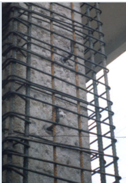
Εκτράχυνση και Χρήση Χαλύβδινων Βλήτρων
