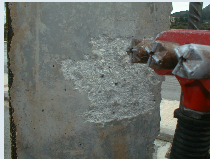
Χρήση Αεροματσάκονου για Εκτράχυνση της Διεπιφάνειας
