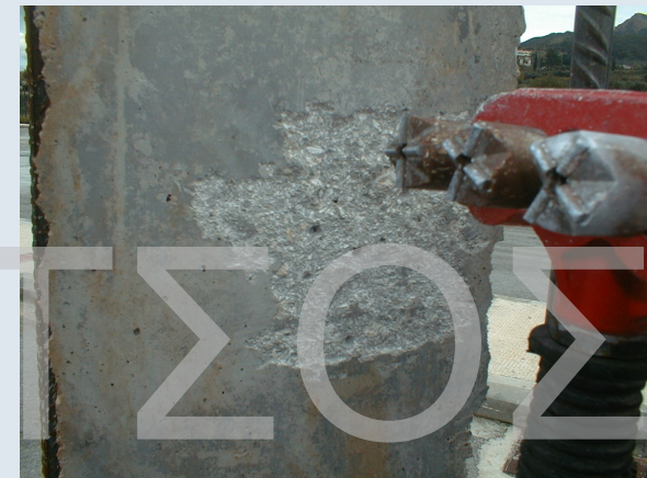
Προετοιμασία Επιφάνειας με Αεροματσάκονο
