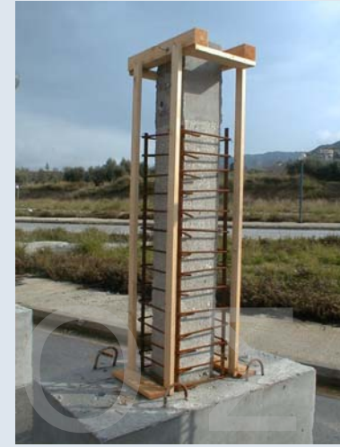
Δοκίμιο Έτοιμο για την Κατασκευή Μανδύα
