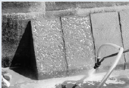
Εκτράχυνση με Αμμοβολή
