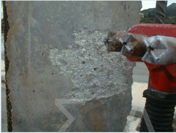
Προετοιμασία Επιφάνειας με Αεροματσάκονο
