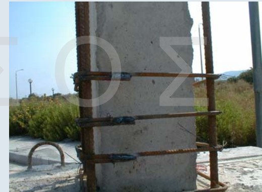
Ηλεκτροσυγκόλληση Άκρων Συνδετήρων Μανδύα
