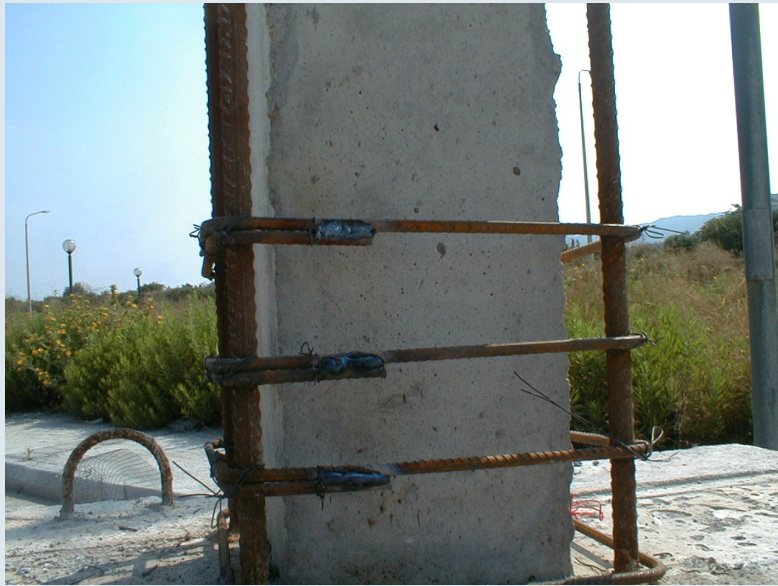
Σ. Η. ΔΡΙΤΣΟΣ Ηλεκτροσυγκόλληση Άκρων Συνδετήρων Μανδύα
