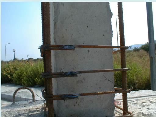
Ηλεκτροσυγκόλληση Άκρων Συνδετήρων Μανδύα
