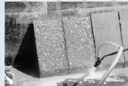
Εκτράχυνση με Αμμοβολή
