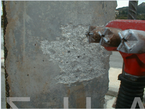
Προετοιμασία Επιφάνειας με Αεροματσάκονο
