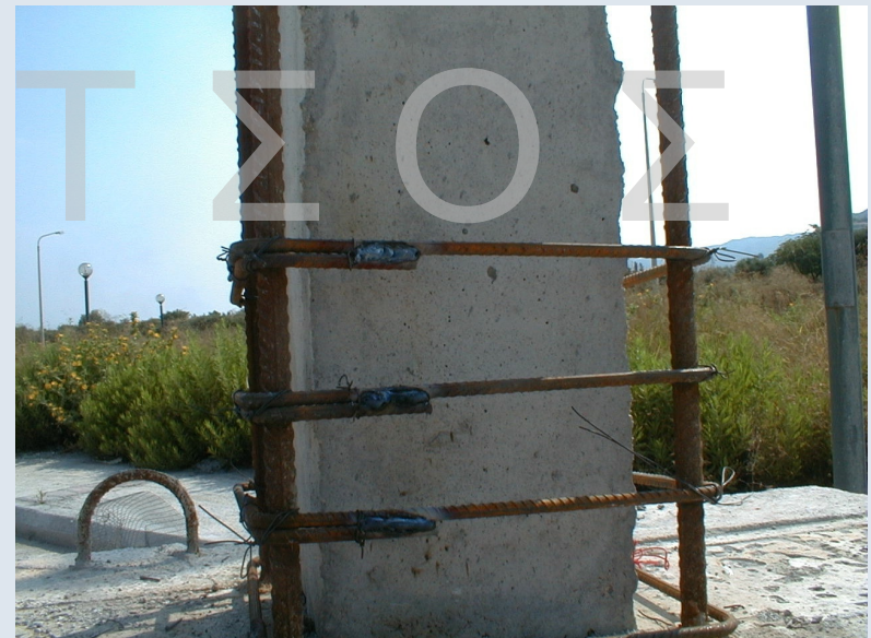
Ηλεκτροσυγκόλληση Άκρων Συνδετήρων Μανδύα
