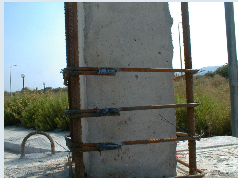
Ηλεκτροσυγκόλληση Άκρων Συνδετήρων Μανδύα
