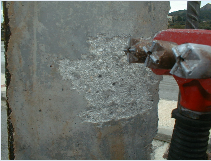
Χρήση Αεροματσάκων για Εκτράχυνση της Διεπιφάνειας
