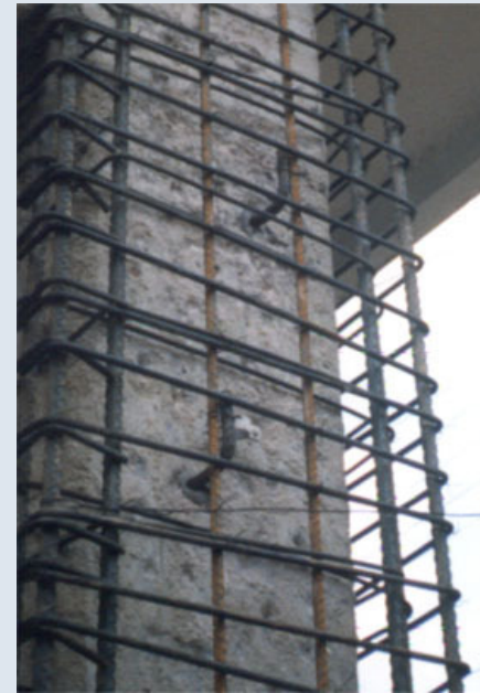
Εκτράχυνση και Χρήση Χαλύβδινων Βλήτρων
