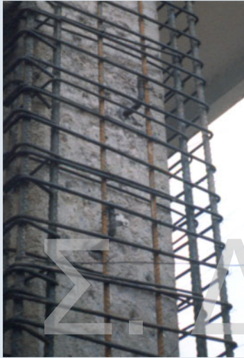
Εκτράχυνση και Χρήση Χαλύβδινων Βλήτρων
