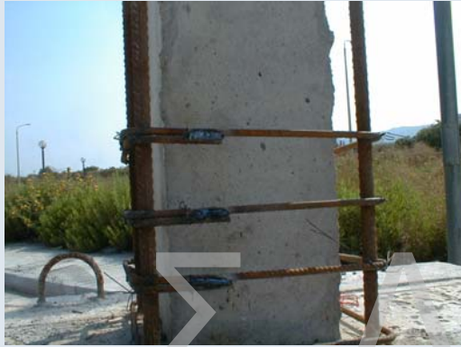
Ηλεκτροσυγκόλληση Άκρων Συνδετήρων Μανδύα
