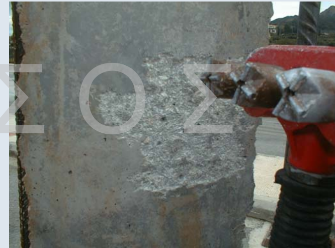
Χρήση Αεροματσάκων για Εκτράχυνση της Διεπιφάνειας
