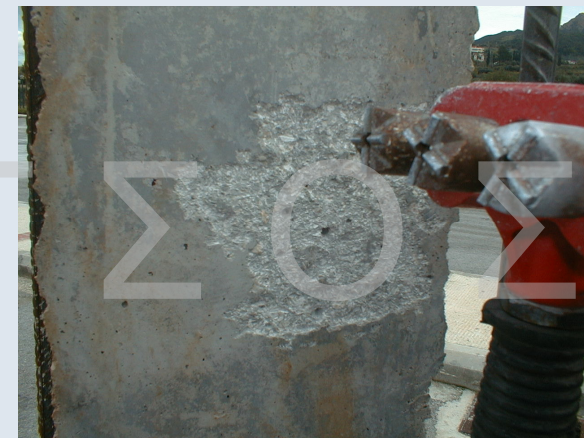
Προετοιμασία Επιφάνειας με Αεροματσάκονο
