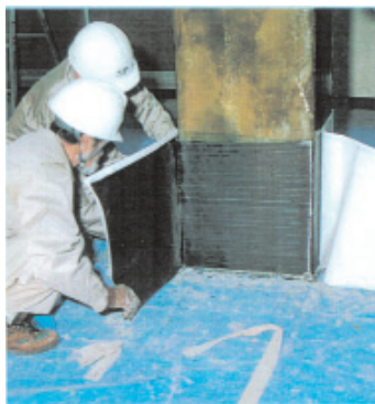
Σχήμα 6: Ενίσχυση με ΙΟΠ (Plakoutas, 2002)
