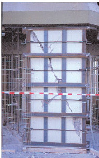
Σχήμα 8: Επέμβαση με μεταλλικό κλωβό για προσωρινή ανάληψη κατακόρυφων φορτίων (Πύργος, 1993)
