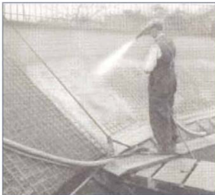
Εικόνα 4: Εκτόξευση σκυροδέματος το 1919 για κατασκευή δεξαμενής νερού [17].
